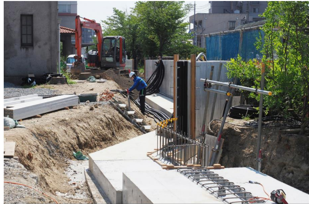
止水壁建設工事 南工区（旧 美和保育園前）。止水壁の工事が進んでいます。
